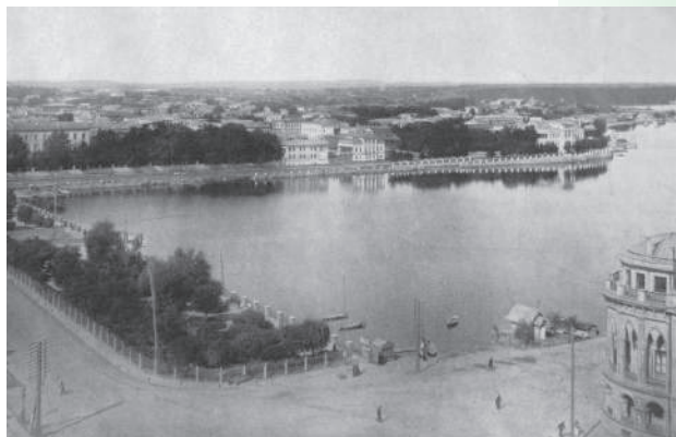
Екатеринбург. Плотина городского пруда. Фото начала XX века
